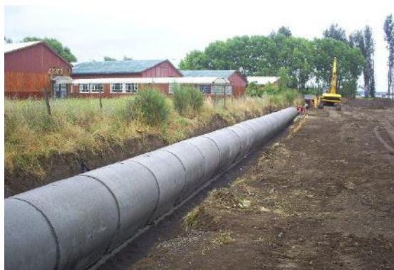
Construcción Obras de evacuación de Aguas Lluvia Estero Las Diucas
